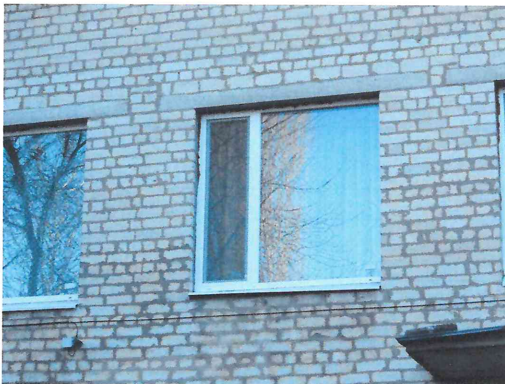
Рисунок 4.2.1. Вигляд вікон будівлі
