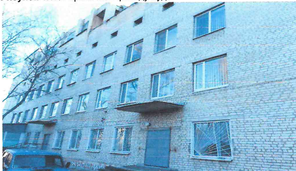
Рисунок 4.1.1. Фрагменти фасаду будівлі
