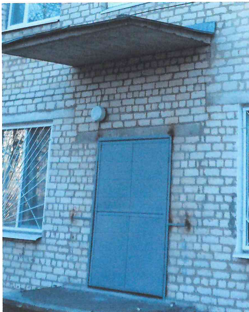
Рисунок 4.3.1. Зовнішній вигляд входних дверей будівлі
