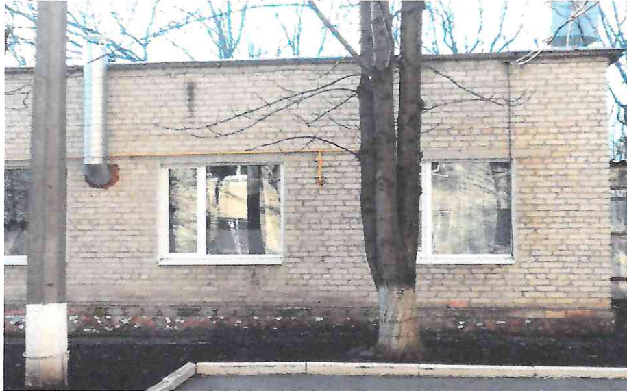
Рисунок 4.1.1. Фрагменти фасаду будівлі
