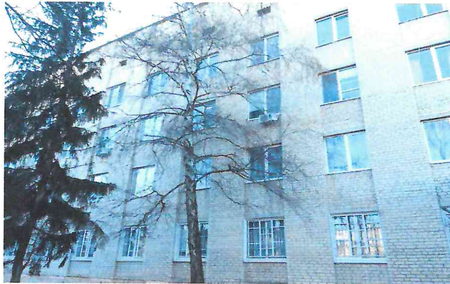
Рисунок 4.1.1. Фрагменти фасаду будівлі
