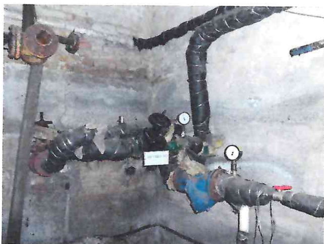
Рисунок 5.1.1. Трубопроводи в підвалі, встановлений тепловий лічильник
